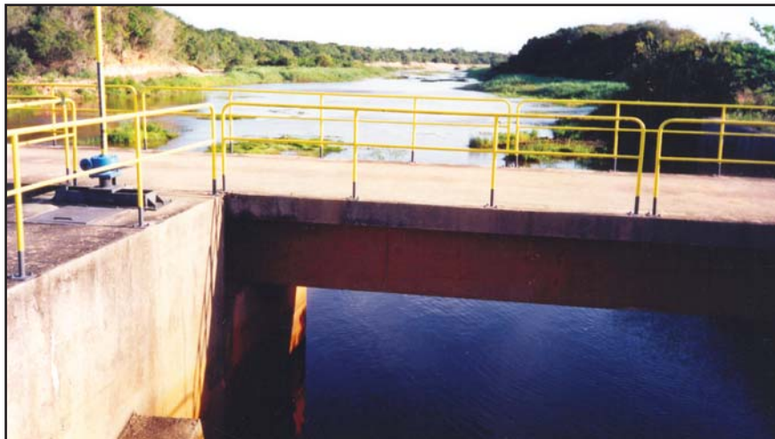
Obras de comportas e barragens nos rios que abastecem a fábrica.
